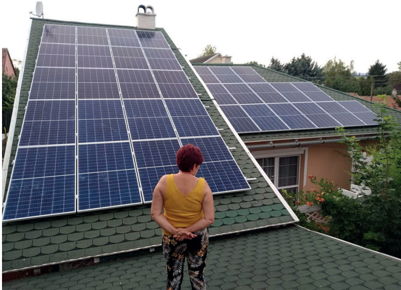
1. ábra: 10,3 kW teljesítményű napelem-rendszer, „HMKE” – saját felvétel
