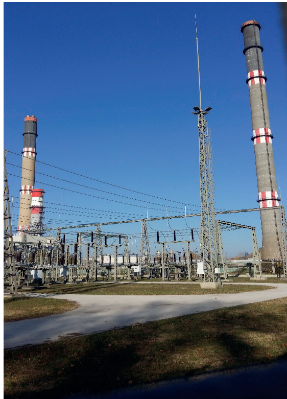
14. ábra. Elhagyott, „leépített” erőmű – saját felvétel
